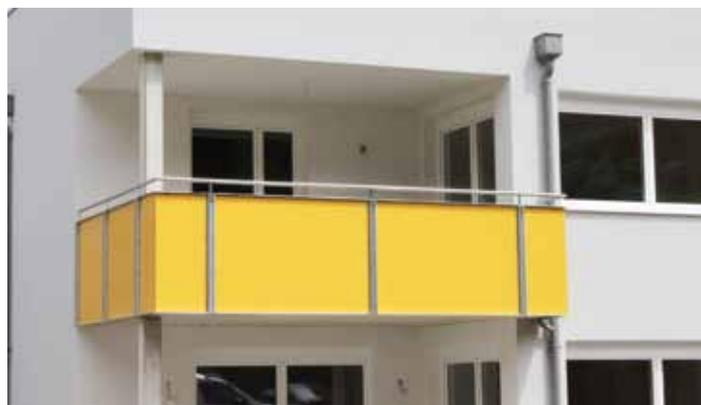
*HPL-Platten wurden speziell entwickelt für den Einsatz im Außenbereich, etwa für Balkonbekleidungen oder Fassadenverkleidungen. Fotos: Senova*
