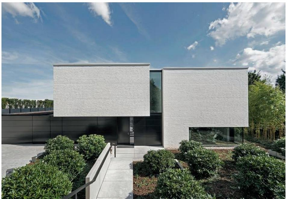
Die Fassaden wurden aus weißem Kalksandstein mit gebrochener Oberfläche gefertigt, der dem Baukörper eine reliefartige Anmutung gibt. Kleinere Fenster einzelner Räume wurden zusammengefasst und kontrastieren mit fenster-
